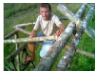
Figura 1. Montagem e amarração dos estipes.
